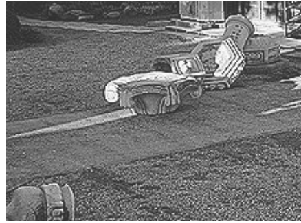
地震で崩れた本堂前の燈籠
